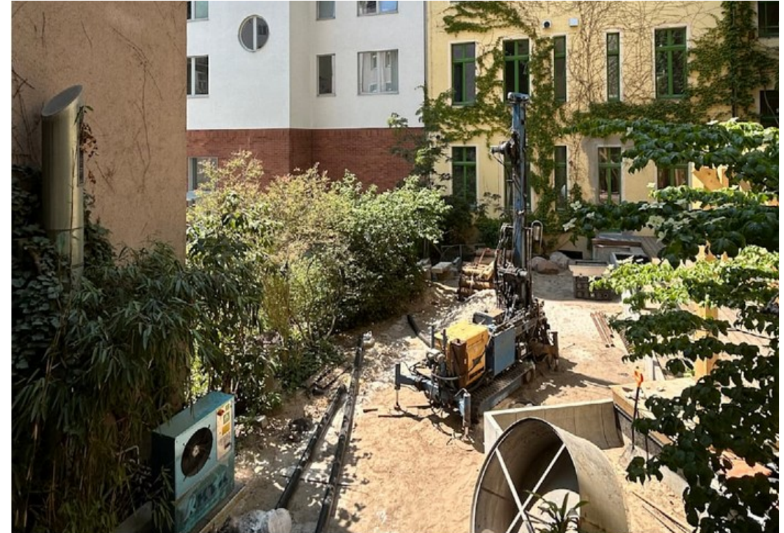
Hier wird für die Wärmepumpe im Innenhof der Grünen-Parteizentrale gebohrt
